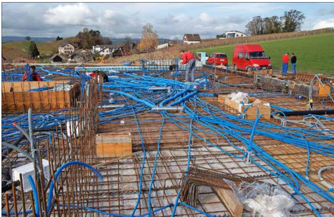
Einlegearbeiten und Installationen an einem neuen Einfamilienhaus.
